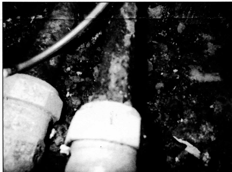
Foto 5: korrodierte Heizungsleitung
