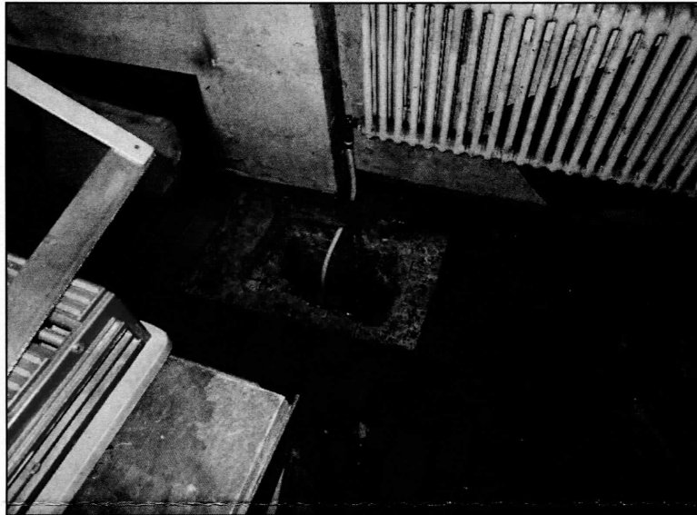
Foto 3: Schacht in der Werkstatt
