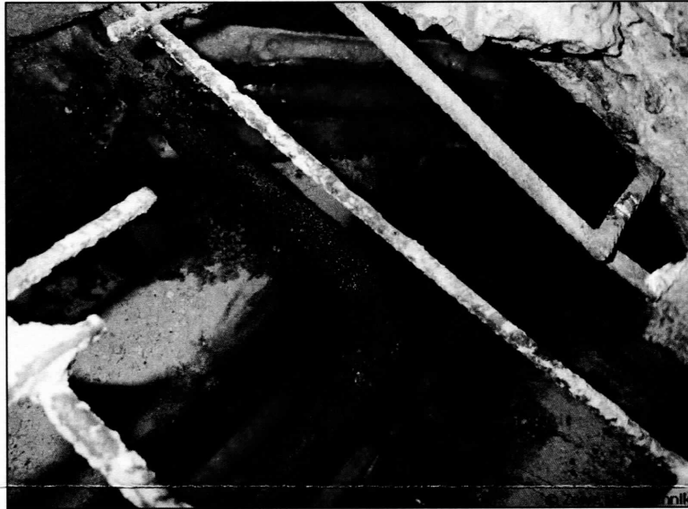
Foto 7: defekte Heizungsleitung lokalisiert
