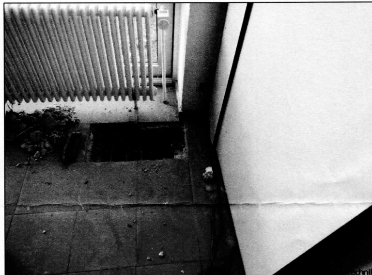
Foto 6: EG Speiseraum Öffnung geschaffen
